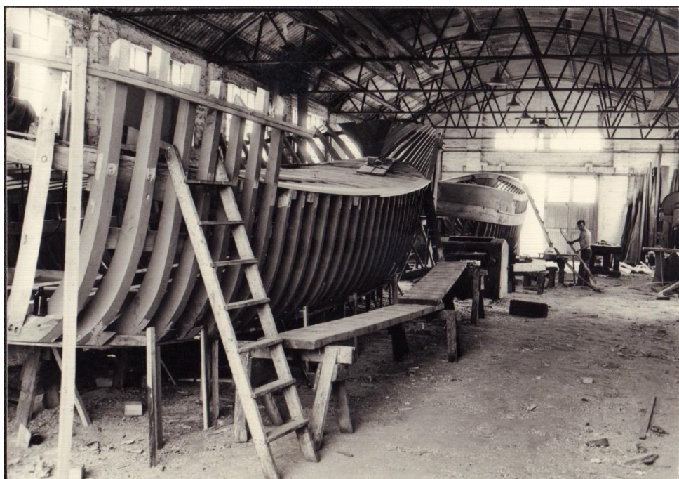
Burcio in costruzione.
